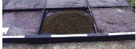
土壌の基礎はフェルトと生ゴミの堆肥とスーパーソル（ガラス廃材）
